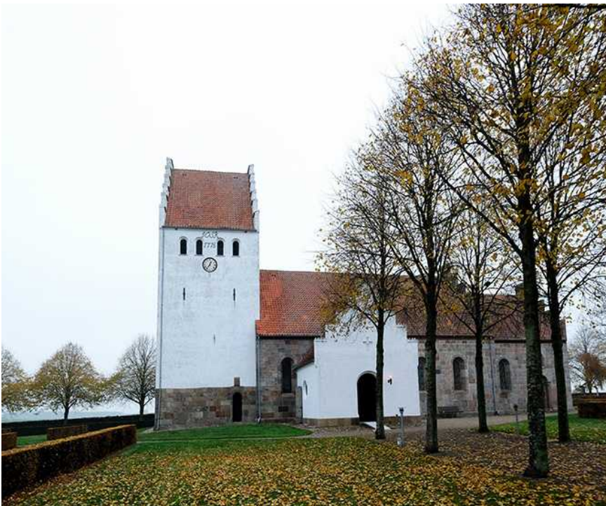
Gosmer Kirke er blevet udbygget og ombygget af flere omgange og har blandt andet fået tårn, våbenhus, kamtakke-gavle og større vinduer end oprindeligt.
