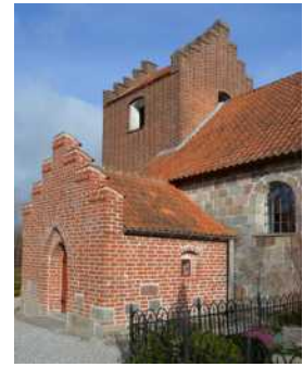
Kasted Kirkes våbenhus fra 1500-tallet er bygget i munkesten men med genbrug af den romanske kirkes kvadre.
